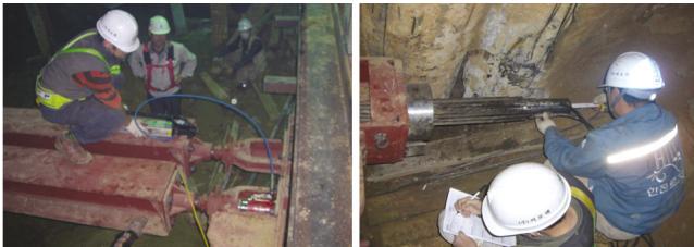
그림 35. IPS 버팀보 가압 및 강선긴장 시공사진(IPS설치완료)
