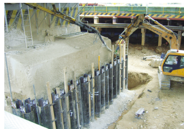
그림 19. C.I.P개선폰법 시공 사진
