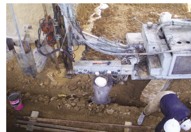
그림 21. S.C.M 시공 사진
